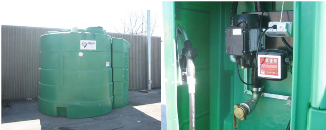
1. att.– Biodīzeļa cisterna un degvielas sūknis
